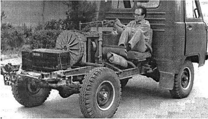
Рисунок 6.10 – Механічний гібрид Гулія Н.В: а – вид збоку; б – вид ззаду (управління гібридом автором Н.В. Гулія (1966 р.)
