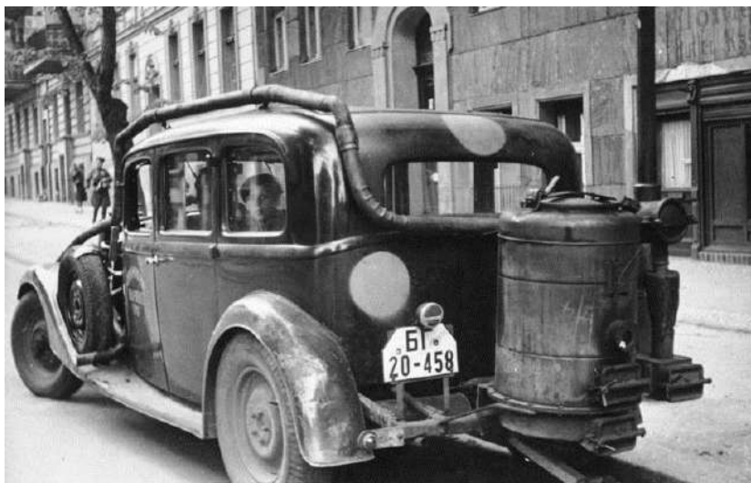
Рисунок 8.8 – Автомобіль обладнаний для роботи на деревному газі (Берлін, 1946 р.)
