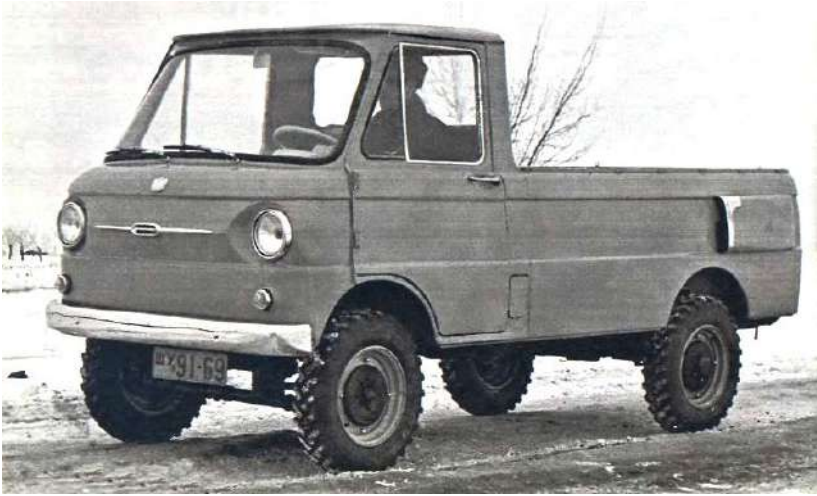
Рисунок 10.21 – Один з перших ЗАЗ-970Г на випробуваннях. Характерну підштамповку на боковинах, таку ж як на ЗАЗ-966, зробили, щоб не збільшувати повітрязабірники системи охолодження
