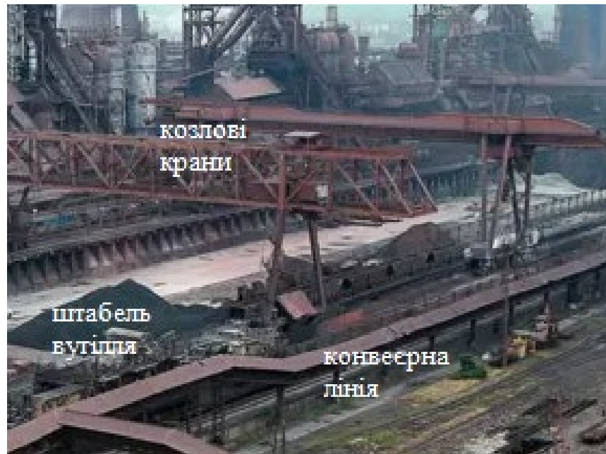
Рисунок 1.3 – Зберігання вугілля на складах та передача до вугільних башт
