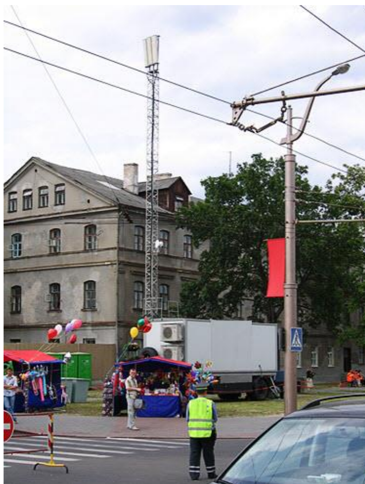
Рисунок 1.2 – Передвижная базовая станция на массовом мероприятии
