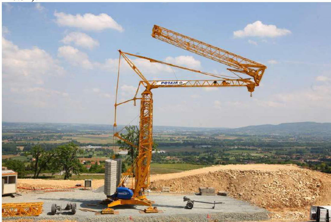
Рисунок 10.31 – Швидкокомунтуємі баштовий кран
