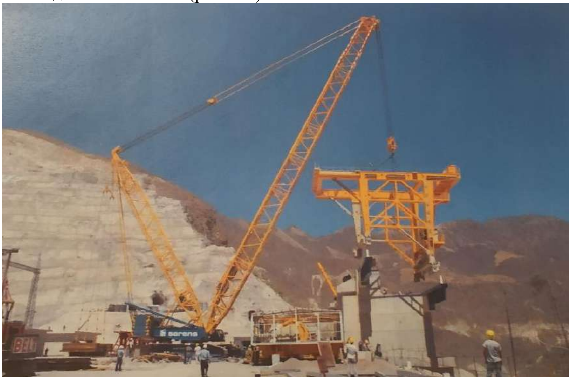
Рисунок 7.2 - Установка портала козлового крана на підкранові колії
