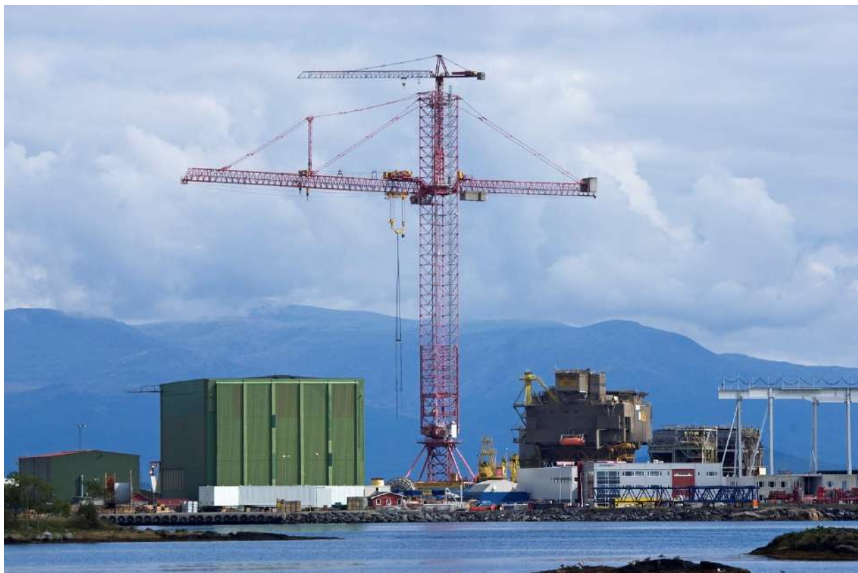
Рисунок 10.25 – Монтажний баштовий кран «Кролл»
