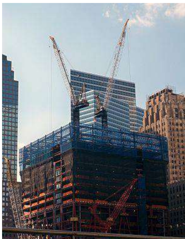
Рисунок 10.6 - Самопідйомні крани на будівництві нового ВТЦ, м. Нью-Йорк
