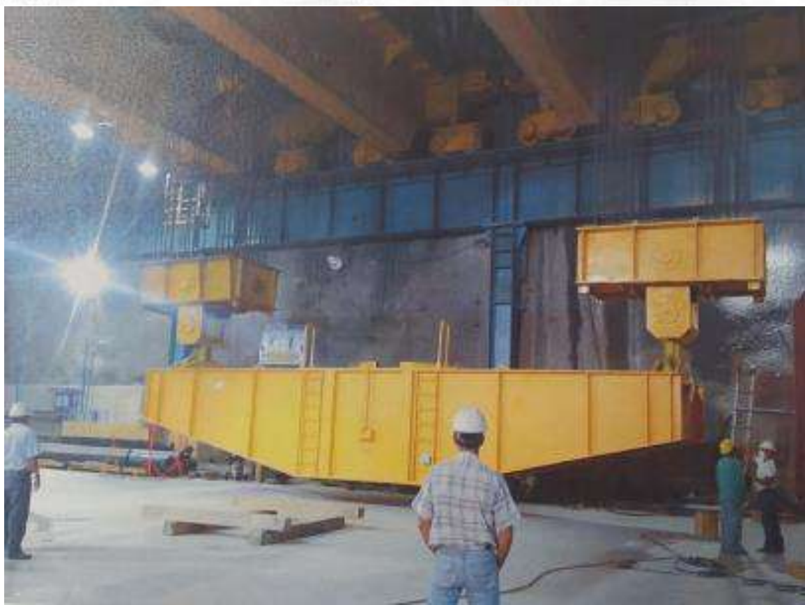
Рисунок 3.11 – Захоплення двома мостовими кранами траверси вантажопідйомністю 720 т
