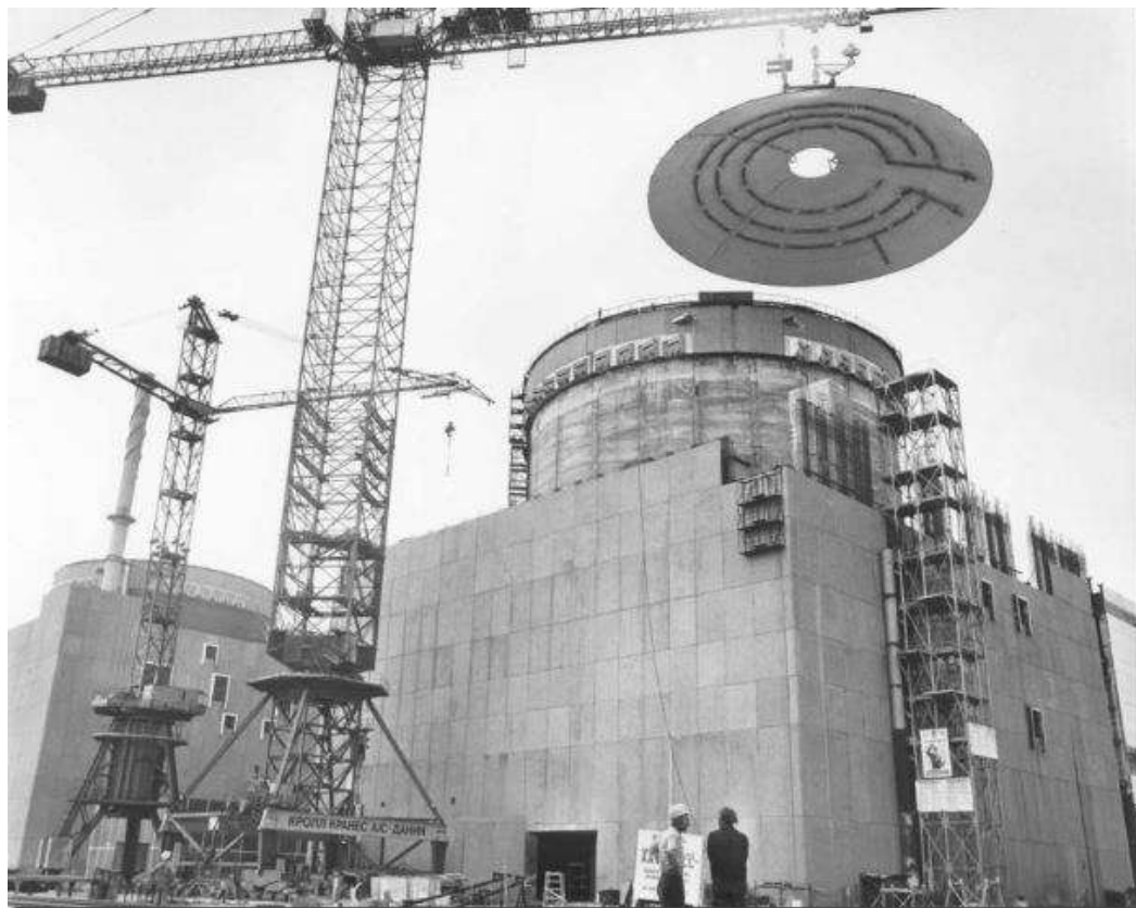
Рисунок 10.27 - Монтаж купола реактора ЗАЕС
