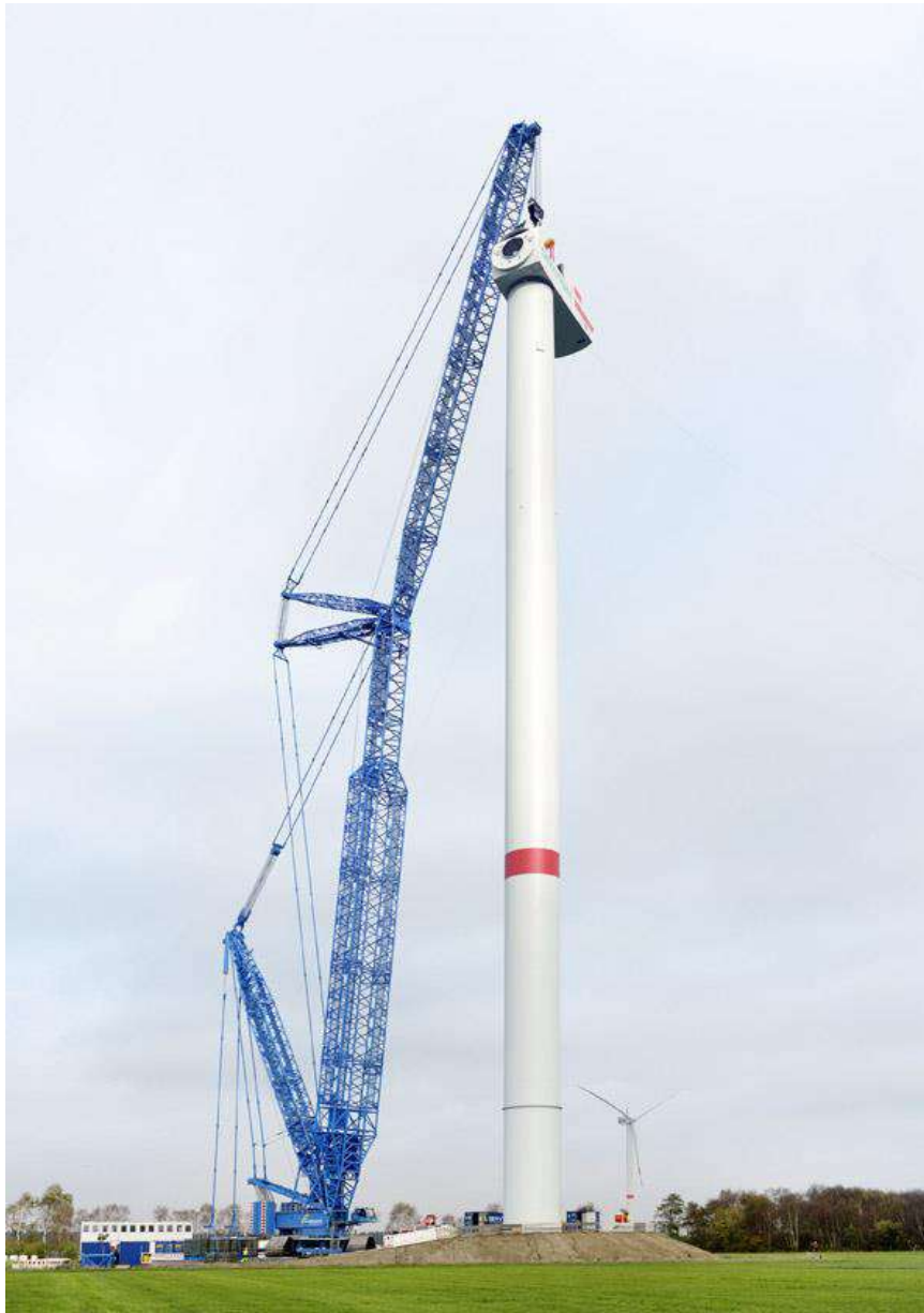
Рисунок 12.16 – Монтаж гусеничним краном вітрової енергетичної установки
