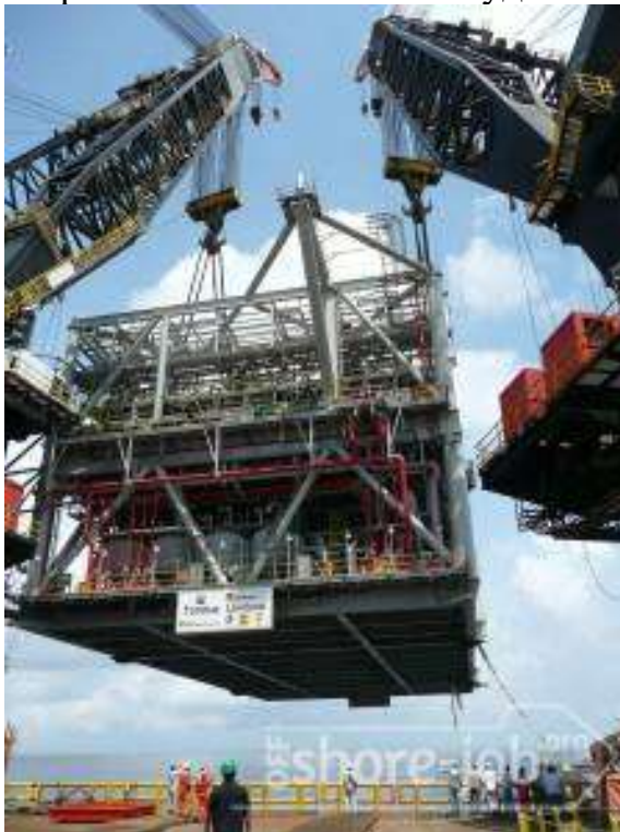
Рисунок 14.28 - Підйом багатотонної верхньої частини нафтової платформи
