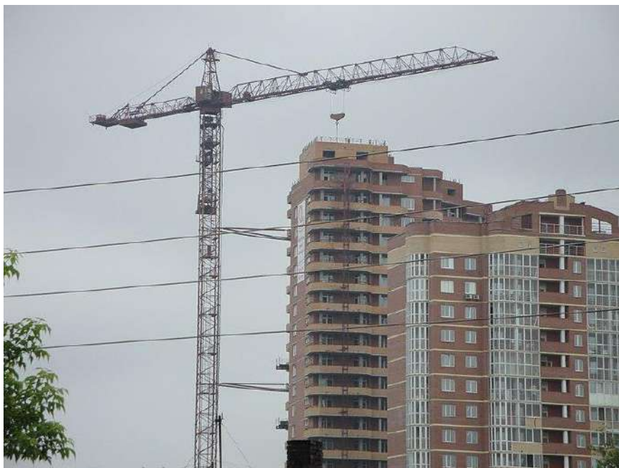
Рисунок 10.5 - Приставний кран, прикріплений до будівлі
