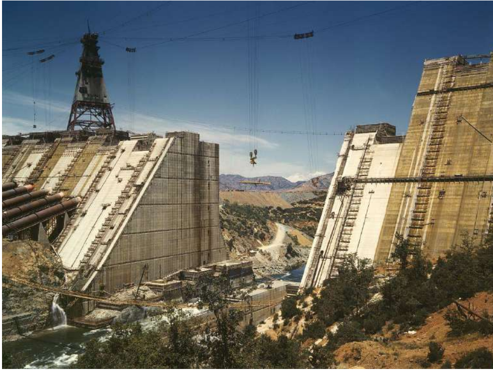
Рисунок 8.1 - Кабельний кран на будівництві дамби
