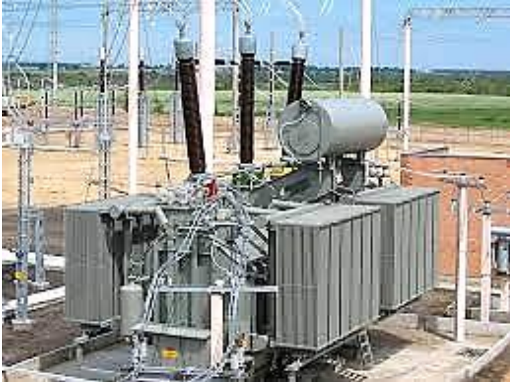
Рисунок 1.5 – Керований підмагнічуванням реактор виробництва ВАТ «Запоріжтрансформатор» [29]
