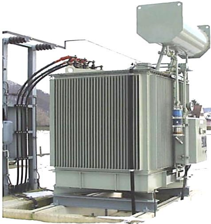
Рисунок 1.3 – Керований підмагнічуванням реактор виробництва TRENCH [73]
