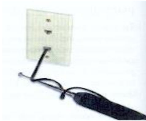
Рисунок 4.6 – Перевірка телефонної лінії
