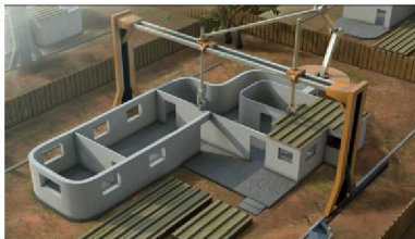
Рисунок 1 – Принцип 3D-друку будинку
