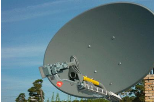
Рисунок 4 - Азимутально-кутомісцева підвіска
