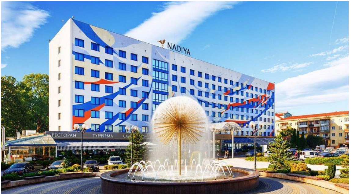
Рисунок 2.2 – Зовнішній вигляд готелю
