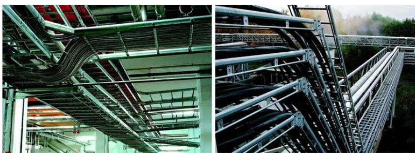
Рисунок 4.4 – Монтаж кабелю всередині будівлі за всіма необхідними вимогами
