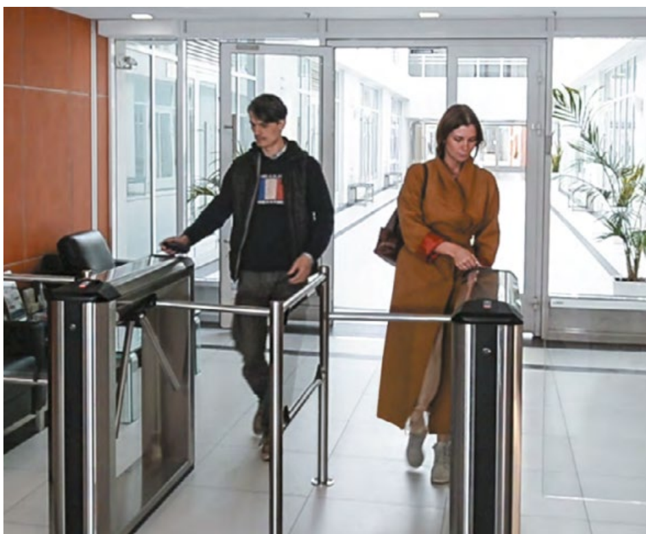
Рисунок 2.4 – Використання турікету-триподу в бізнес-центрі
