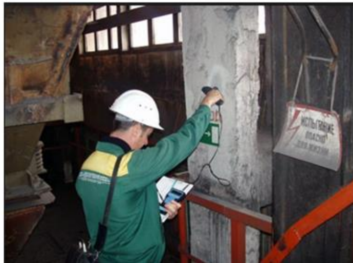
Рисунок 1.8 – Перевірка захисного шару залізобетонної конструкції
