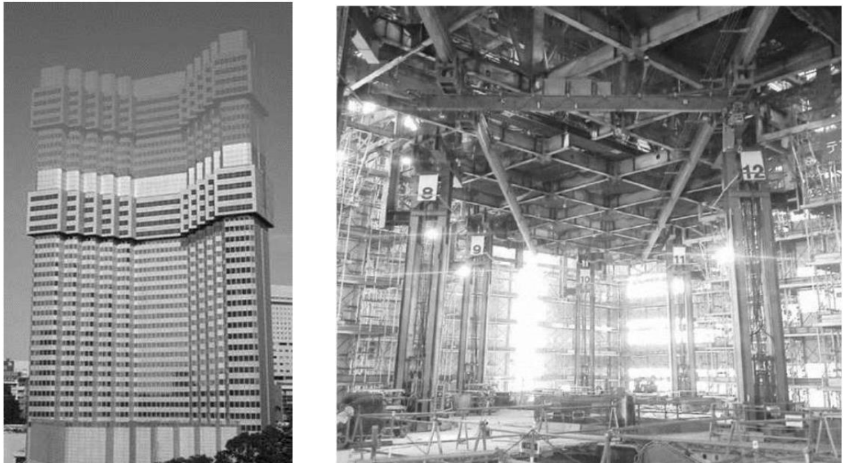
Рисунок 2.9. Використання МТМК (Taisei Corporation) при демонтажі будівлі
