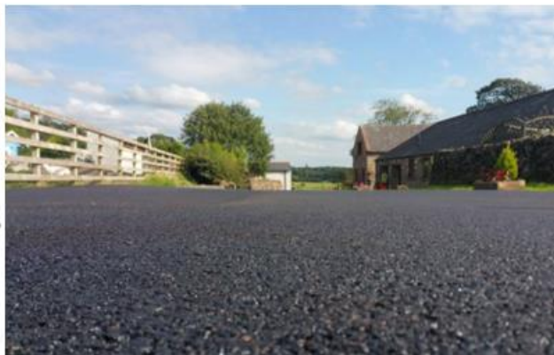
Рисунок 2.14 Гранули MR6 та дорожнє покриття MacRebur.
