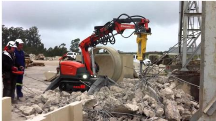
Рисунок 1.22 – Розбирання залізобетонних перекриттів
