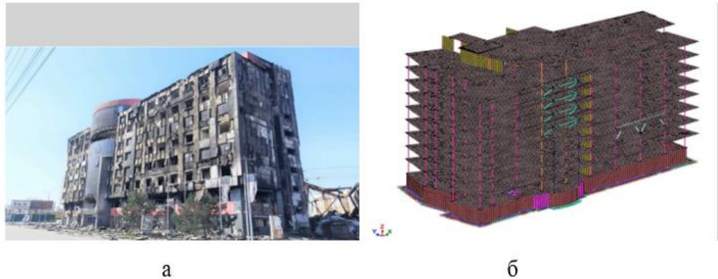
Рисунок 1.5 а- загальний вигляд та б- чисельна модель пошкодженої будівлі.
