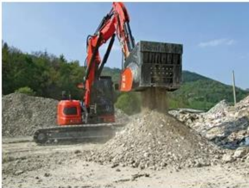
Рисунок 3.4. Екскаватор оснащений ковшем для просіювання
