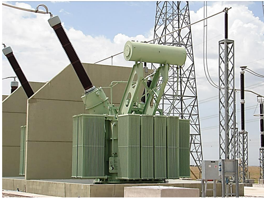
Рисунок 3.1 – Шунтувальний реактор РОМ-50000/500 виробництва ПрАТ ЗТР (Запоріжжя, Україна) [29]
