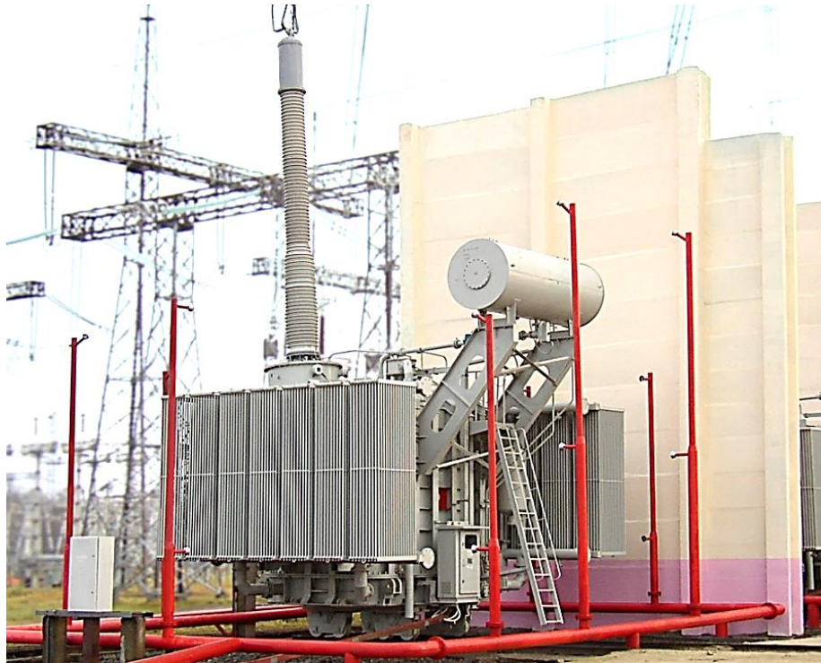
Рисунок 3.3 – Нейтральний реактор РОМ-110000/750 виробництва ПрАТ ЗТР (Запоріжжя, Україна) [29]
