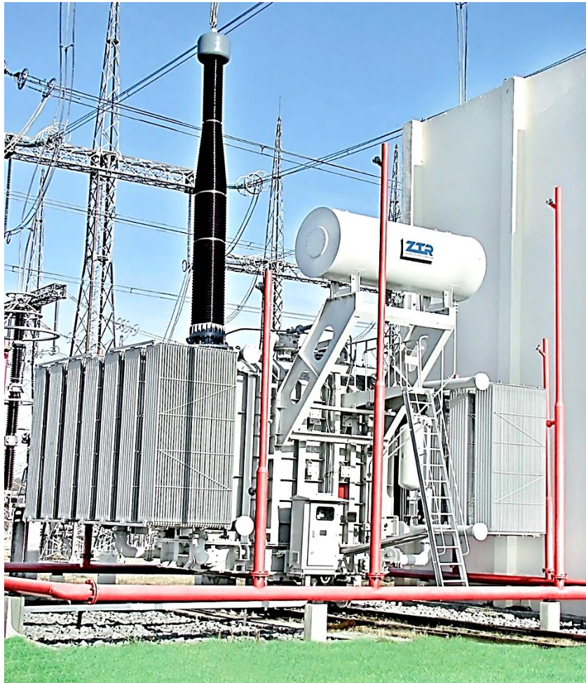
Рисунок 3.2 – Шунтувальний реактор POM-60000/500 виробництва ПрАТ ЗТР (Запоріжжя, Україна) [29]
