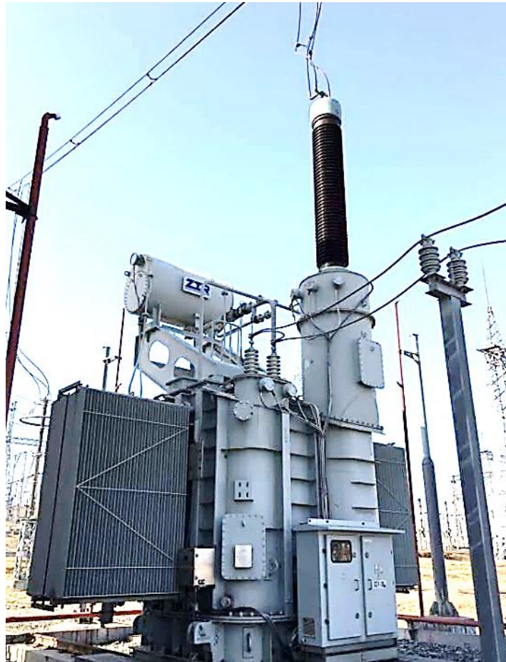
Рисунок 3.6 – Фотографія реактора типу РОМ-60000/500-У1 виробництва ЗТР ПрАТ (Запоріжжя, Україна) [29]
