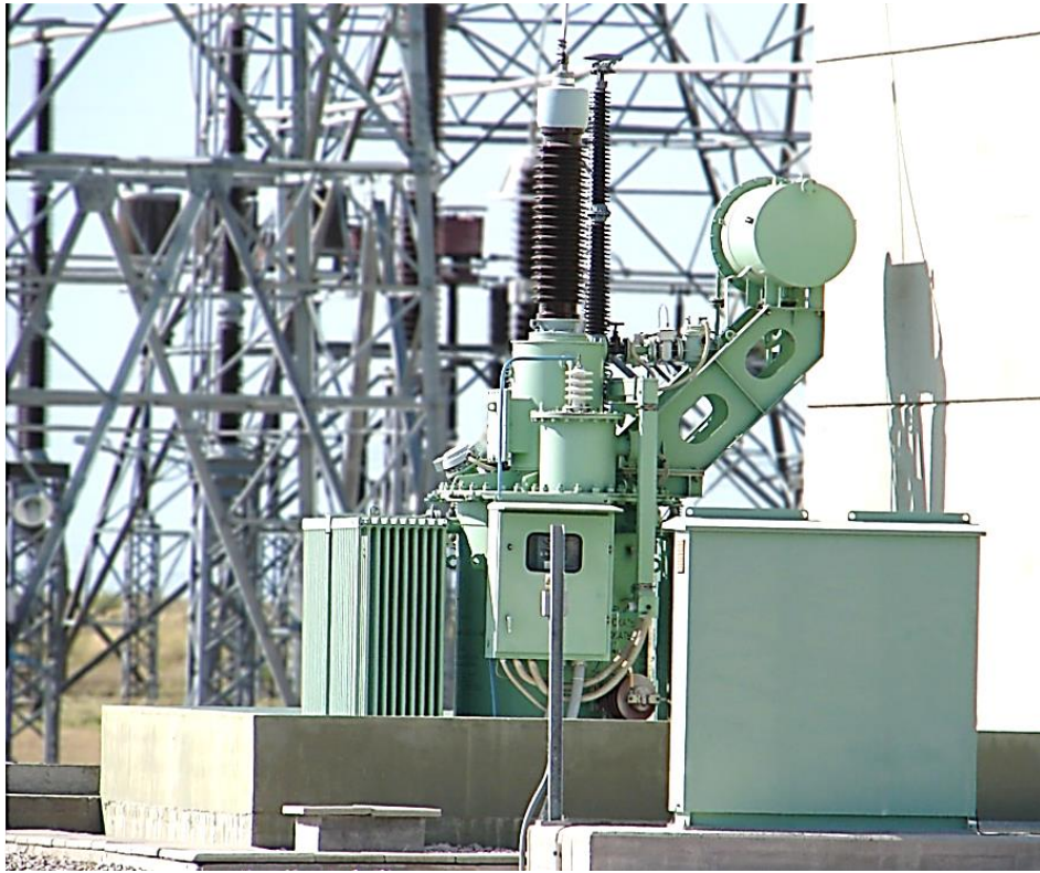
Рисунок 3.4 – Шунтувальний реактор РОМ-84/123 виробництва ЗТР ПрАТ (Запоріжжя, Україна) [29]
