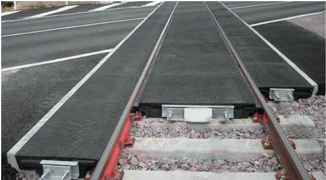
Рисунок 2.4 – Приклад використання залізо-гумового настилу на переїзді
