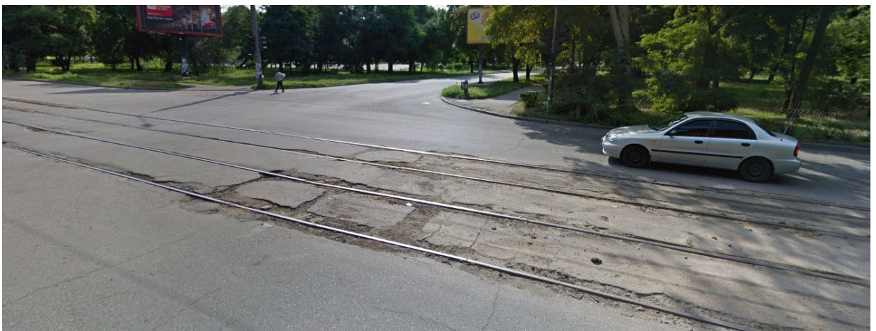
Рисунок 2.2 – Стан пішохідних переходів в межах впливу трамвайних колій на перехресті вул. Незалежної України – вул. В. Зайцева
