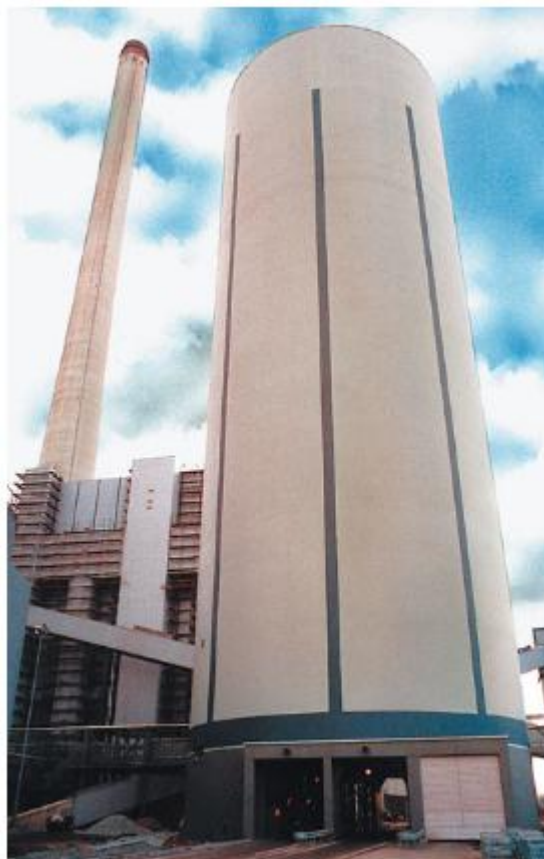
Рисунок 1.4 – Склад силосного типу для зберігання та відвантаження на транспортні засоби сухої золи
