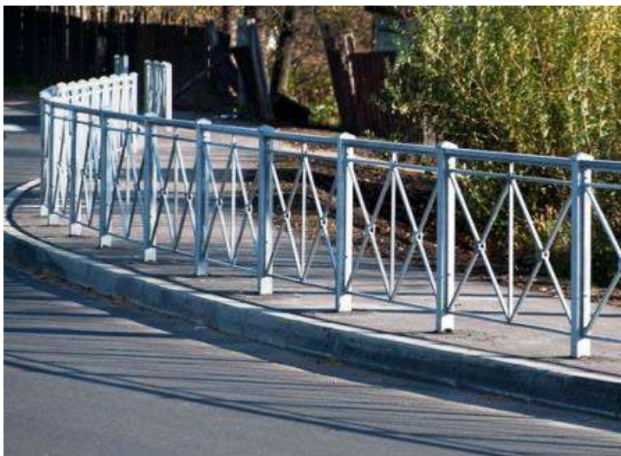
Рисунок 2.4 – Приклад використання пішохідної огорожі
