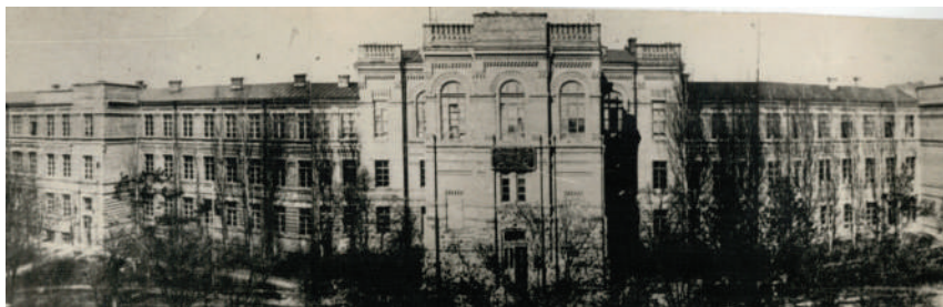
Відбудована машинка з неповністю заскленими вікнами. 1949 р.
