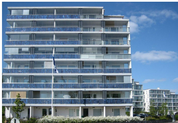
Рисунок 6.1 – Квартал будівель із зниженими енерговитратами у Фінляндії. У фасад будівлі вбудовані панелі, що збирають сонячну енергію
