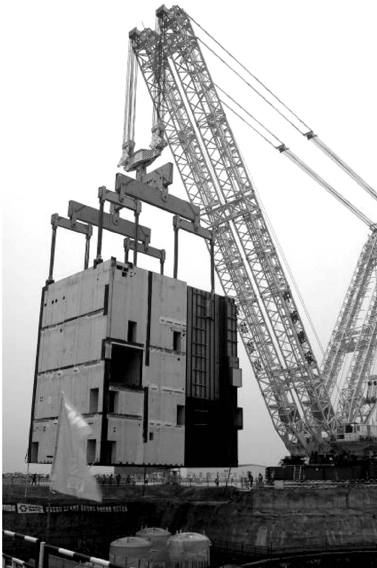
Рисунок 1.8 – Кран ХСМГ ХGC88000 зі спеціальною балансирною системою траверз.
