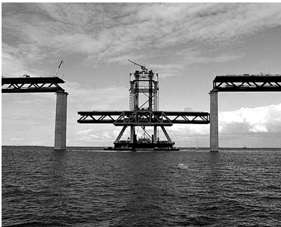
Рисунок 1.12 – Кран «Svanen» зі спеціальним вантажозахватним пристроєм під час монтажу пролітної будови мосту.
