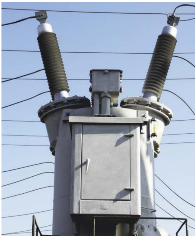
Рисунок 1.1 – Масляний вимикач 220 кВ [2, 4].
