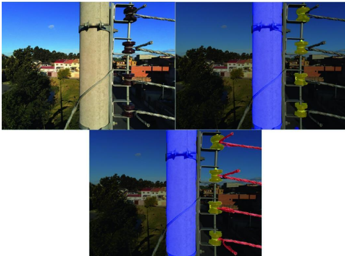
Рисунок 2.11 – Виділення ключових частин для аерофотографування за допомогою машинного зору
