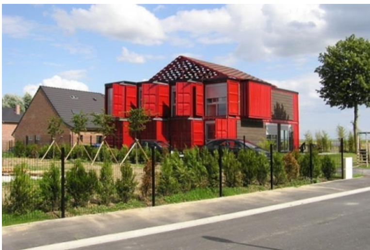
Рисунок 6.2. - Житлова будівля з контейнерів
