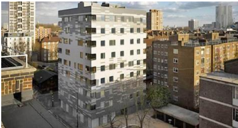
Рисунок 4.2.- Перший із сучасних житлових будинків, побудований з дерева по сучасних технологіях дерев'яного домобудівництва. Лондон.
