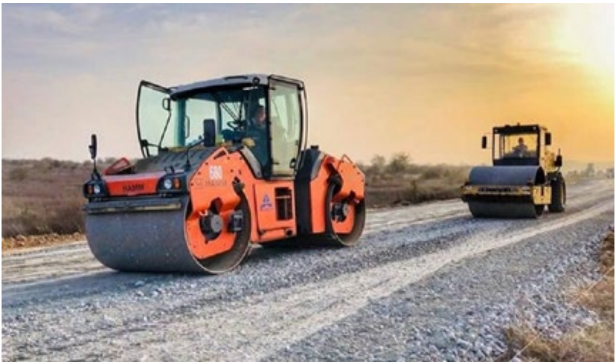
Рисунок 1.2 – Будівництво автодороги з використанням гранульованого шлаку
