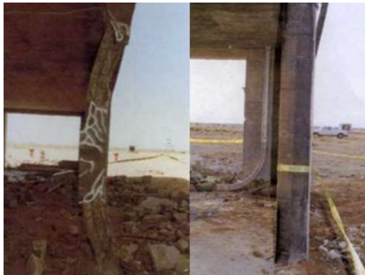
Рисунок 6.8 – Використання вуглепластику для посилення колон (з ним та без відповідно) [50]
