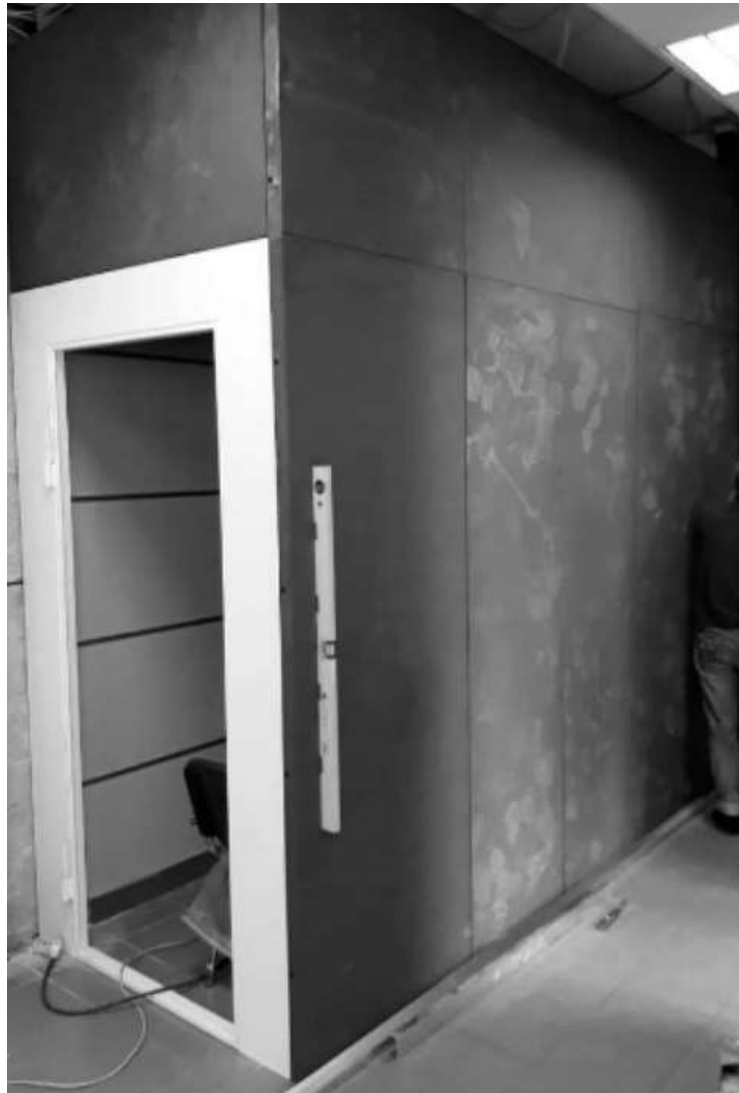
Рисунок 6.9 – Використання вибухостійких панелей
