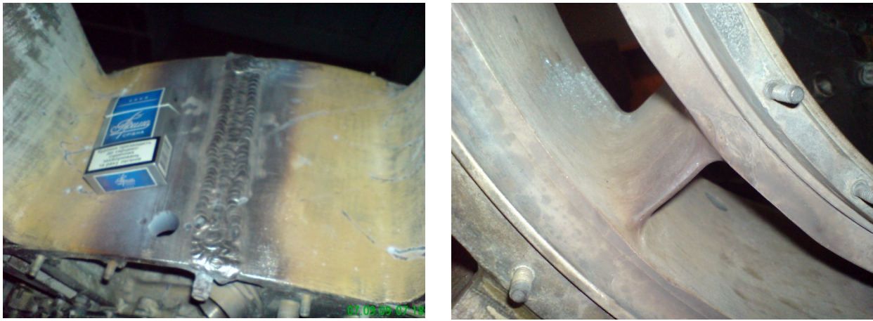
а – після заварки; б – після зачистки відновлених ділянок
