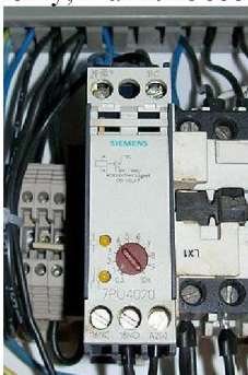
Рисунок 1 -Електромагнітне реле часу
