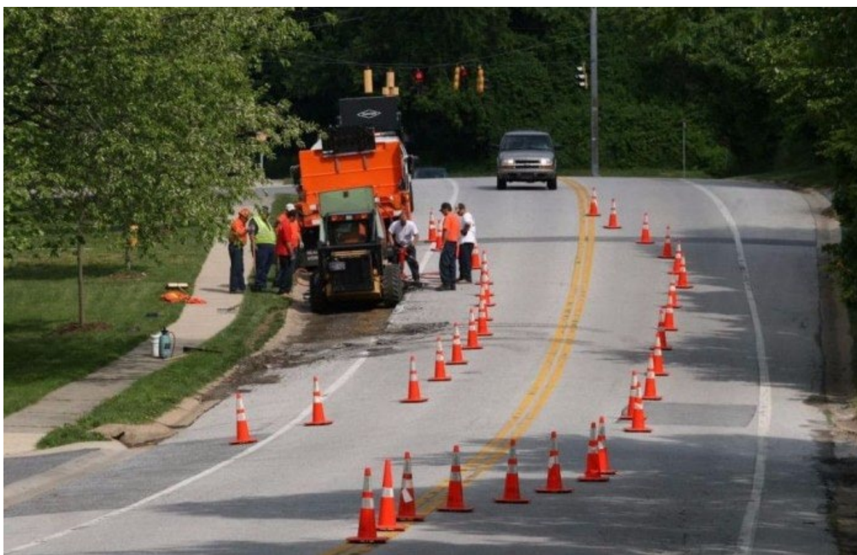
Рисунок 2.5 – Використання тимчасових пристроїв каналізування руху
