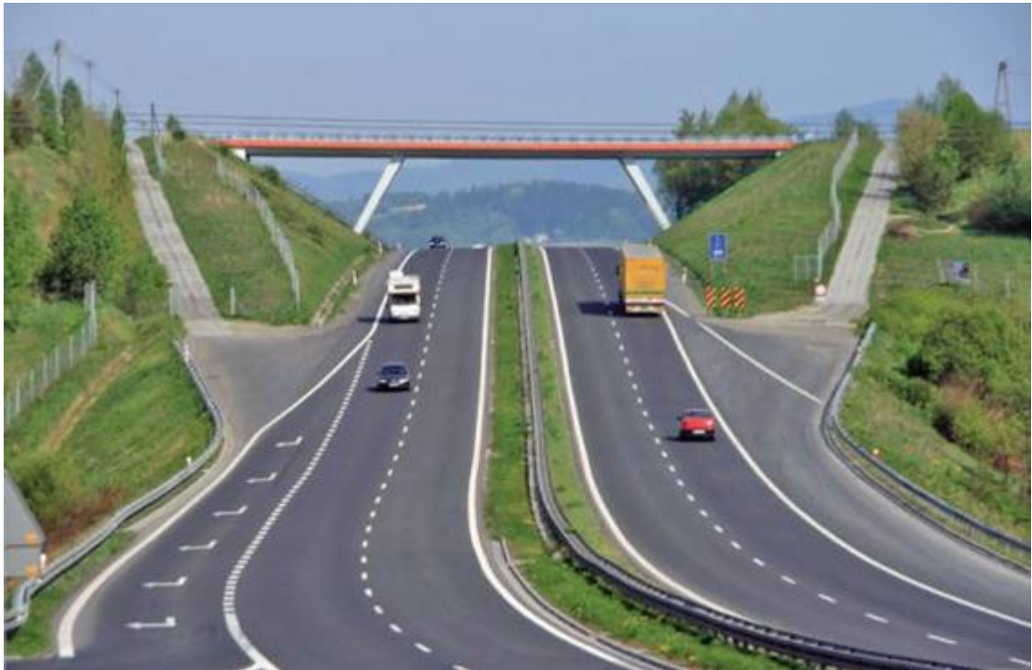
Рисунок 2.3 – Приклад каналізування руху на перегонах
