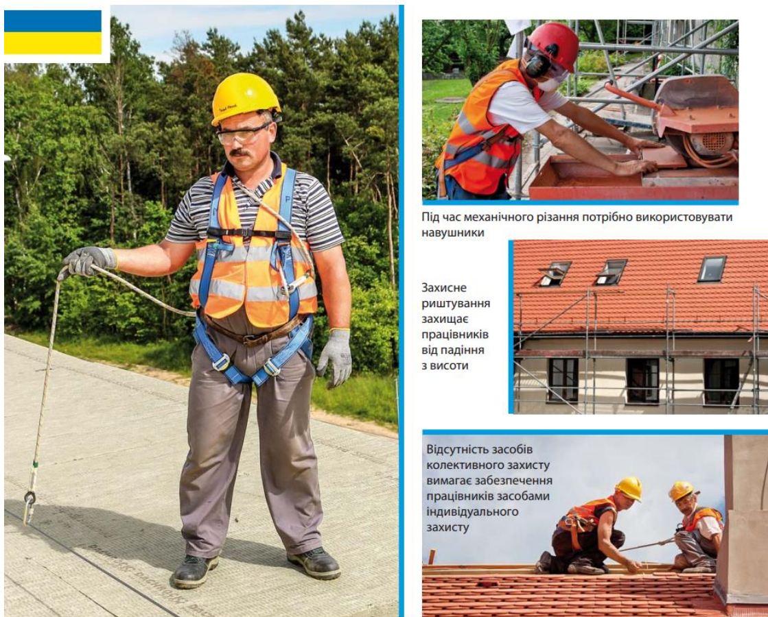
Рисунок 5.1 – Принципи безпеки праці при виконання покрівельних робіт
