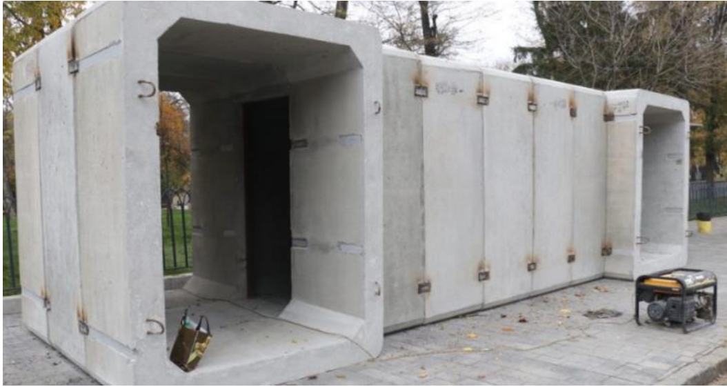
Рисунок 5.2 – Використання мобільного укриття при будівельних роботах
