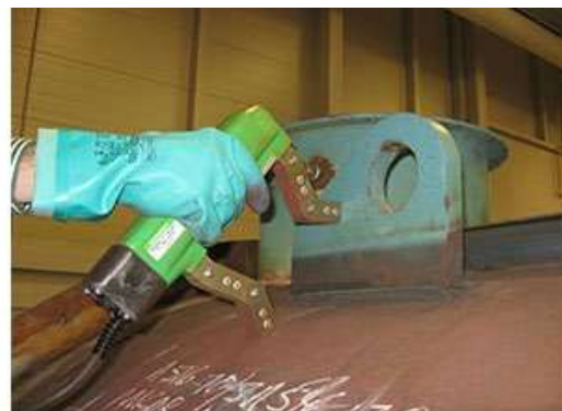
Перевірка МТ зварного шва підйомної проушини на працюючому котлі.
