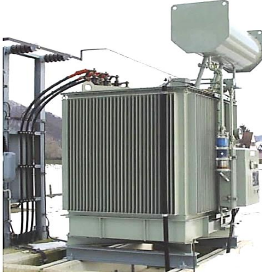
Рисунок 7.5 – Масляний баковий дугогасний реактор зі сталевим магнітопроводом на напругу 20 кВ потужністю 5000 кВАр виробництва компанії Trench® Austria GmbH [118]
