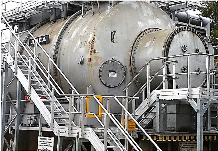
Рисунок 6.4 –Синхронний компенсатор, Мельбурн, Австралія [112]
