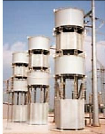
Рисунок 7.19 – Регулювальні реактори послідовного включення [118]:
