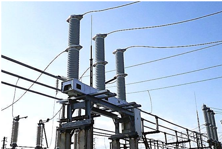
Рисунок 9.13 – Конструкція вакуумного вимикача серії ВРС-110 [61, 79, 81]
