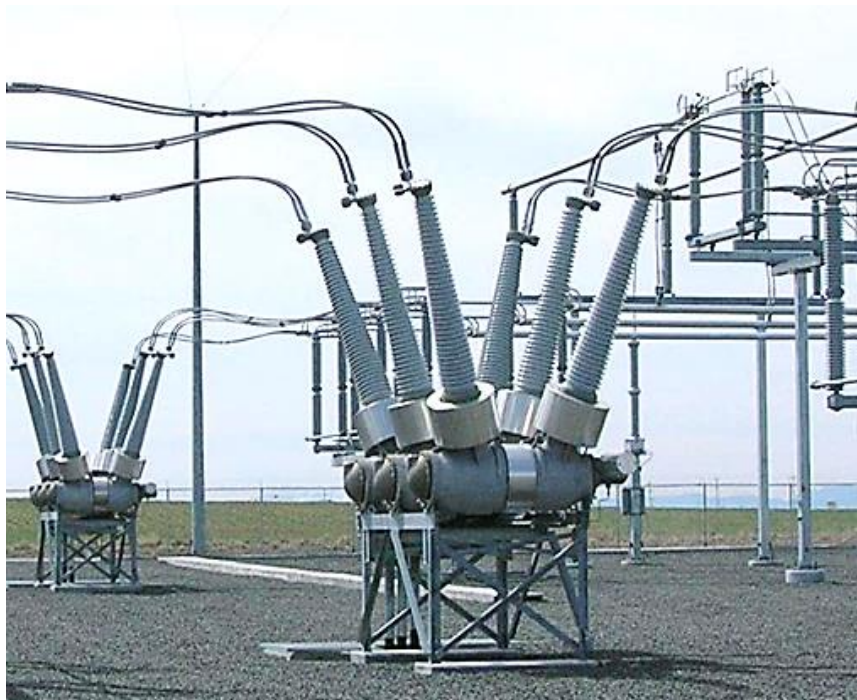
Рисунок 9.20 – Елегазовий вимикач 220 кВ [72]
