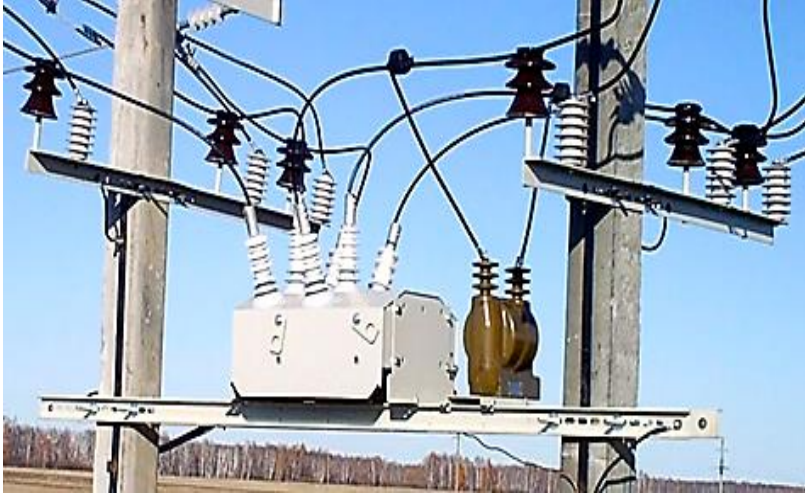
Рисунок 10.1 – Малогабаритний розподільний пристрій для аналізу роботи мережі повітряних ЛЕП та захисту ліній від аварійних ситуацій [113]
