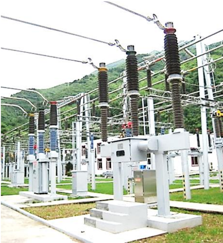
Рисунок 9.27 – Гібридний вимикач, встановлений в Харшита Сети, Шивани Ашра, Сукрити Лал
