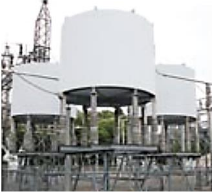
Рисунок 7.19 – Регулювальні реактори послідовного включення [118]:
