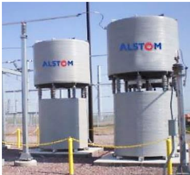
Рисунок 7.4 – Шунтувальні реактори виробництва французької компанії Alstom [95]
