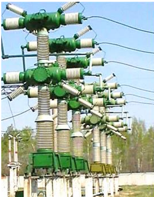
Рисунок 9.5 – Повітряний вимикач 220 кВ
