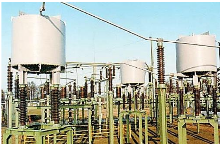
Рисунок 7.10 – Однофазні реактори послідовного включення виробництва компанії Сименс Trench® Austria GmbH [81, 118]
