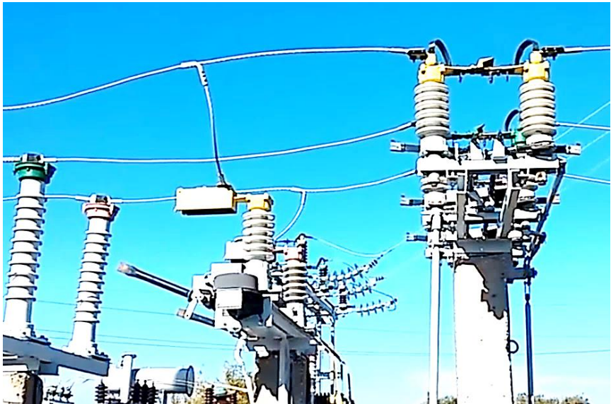
Рисунок 12.7 – Відокремлювач відкритої конструкції
