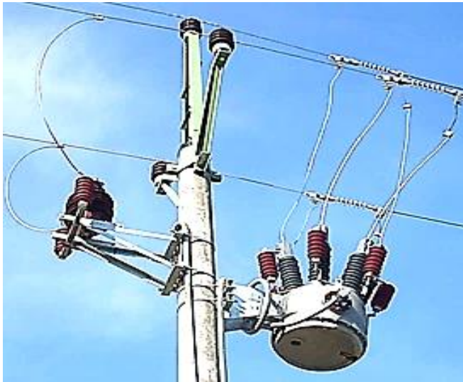
Рисунок 10.7 – Реклоузер зовнішній вигляд вимикача GVR Recloser [113]
