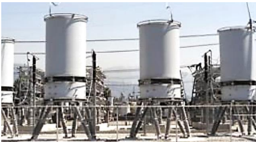
Рисунок 7.8 – Фільтрові реактори на номінальну напругу 230 кВ підвищеної сейсмостійкості виробництва компанії Сименс (Trench® Austria GmbH) [118]
