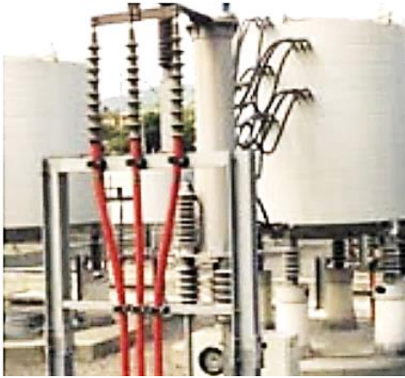
Рисунок 7.9 – Буферні реактори для електричних дугових печей виробництва компанії Сименс (Trench® Austria GmbH) [118]
