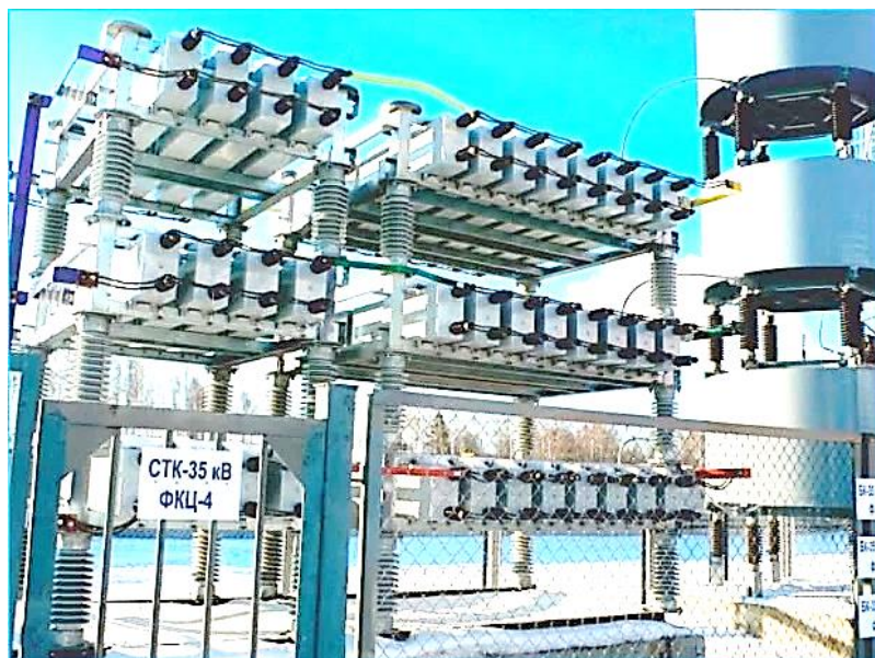
Рисунок 6.12 – Статичний тиристорний компенсатор реактивної потужності модульного виконання із системою повітряного охолодження [82]
