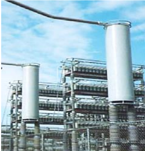
Рисунок 7.11 – Струмообмежувальний реактор для конденсаторних батарей [70, 81]
