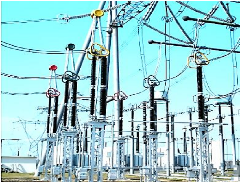
Рисунок 3.19 – Види гнучких струмопроводів у ВРП-220 кВ [93, 99]
