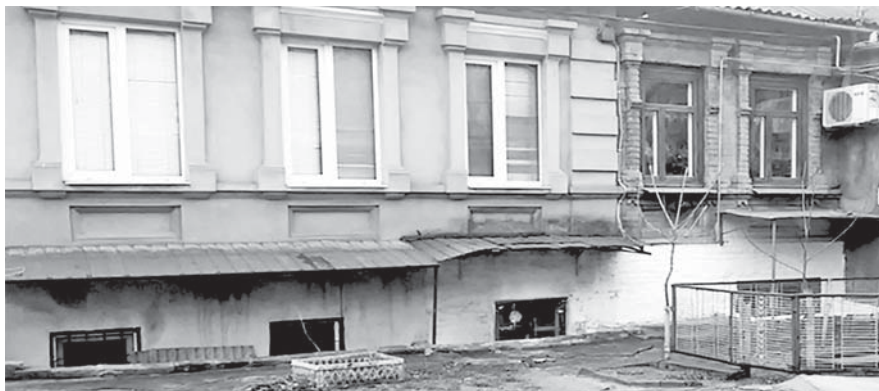
Фото 7. Будинок на вул. Поштовій, 7
