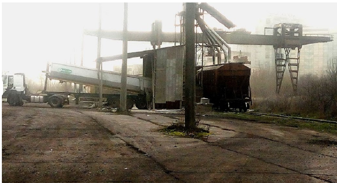
Рисунок 1.13 – Загальний вигляд стаціонарних вантажних пристроїв станції Гнідава
