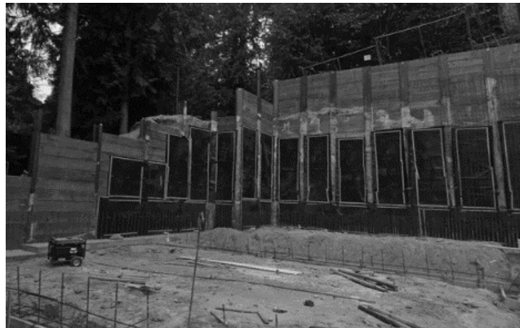
Рисунок 5.5 – Будівництво об'єкту на покатих схилах
