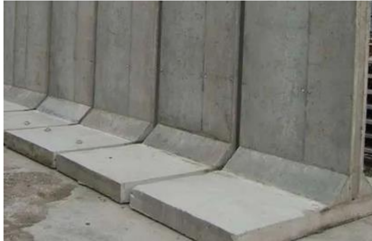
Рисунок 5.8 – Загальний вигляд підпірної стіни
