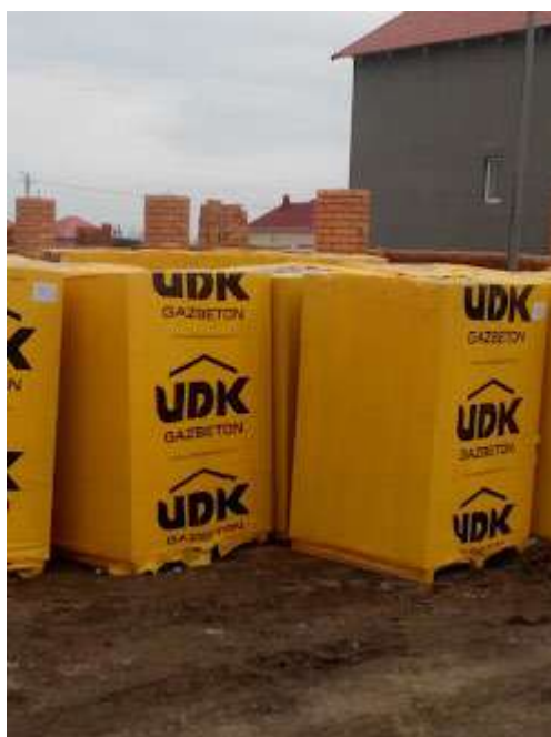
Рисунок 1.14 – Розміщення піддонів із газобетоном у споживача
