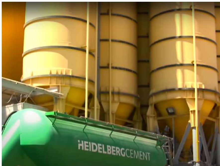
Рисунок 1.6 – Зберігання сировини у силосах
