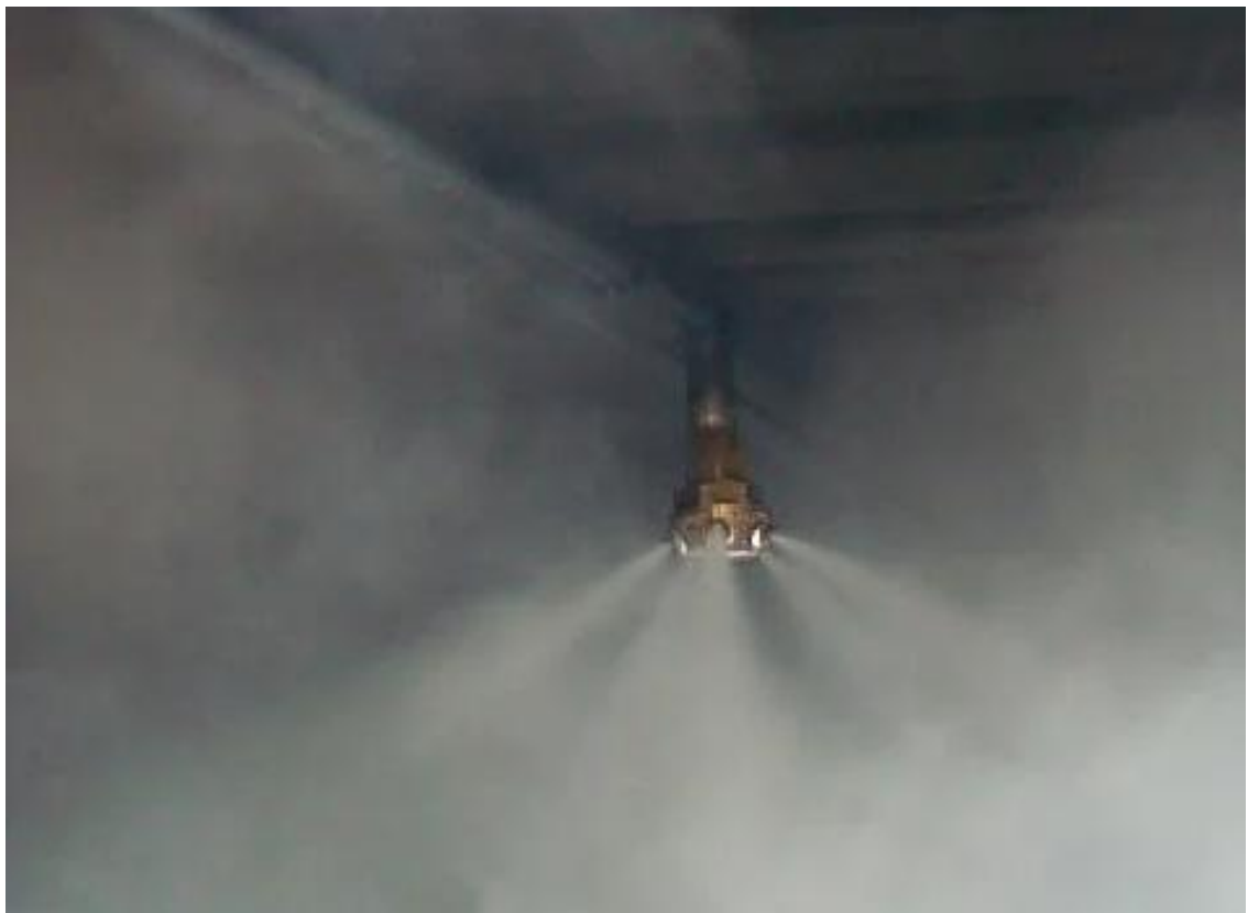
Рисунок 2.4 – Перевірка роботоздатності системи розпилення
