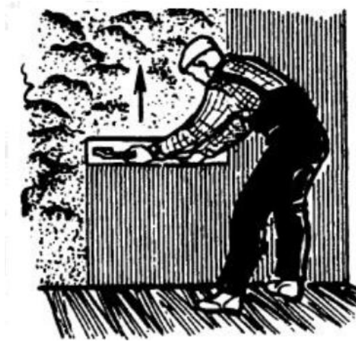
Рисунок 3.19 - Розрівнювання розчину напівтерком
