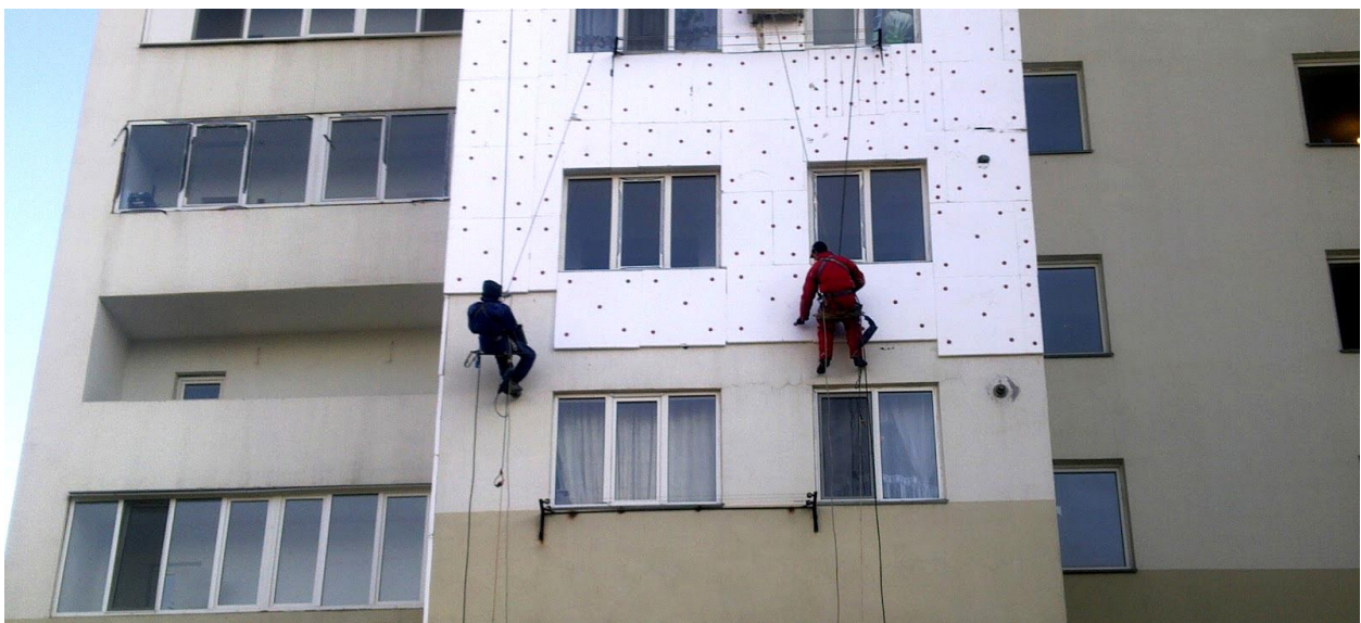
Рисунок 6.9 – Утеплення фасаду пінополістиролом
