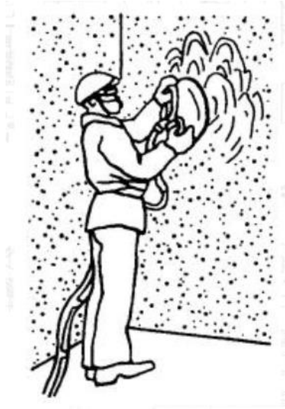
Рисунок 3.21 - Механізоване затирання поверхні
