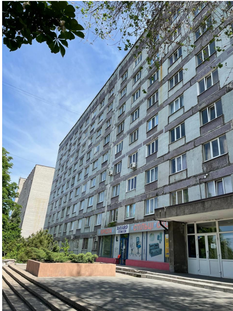
Рисунок 1.1 – Головний фасад будівлі
