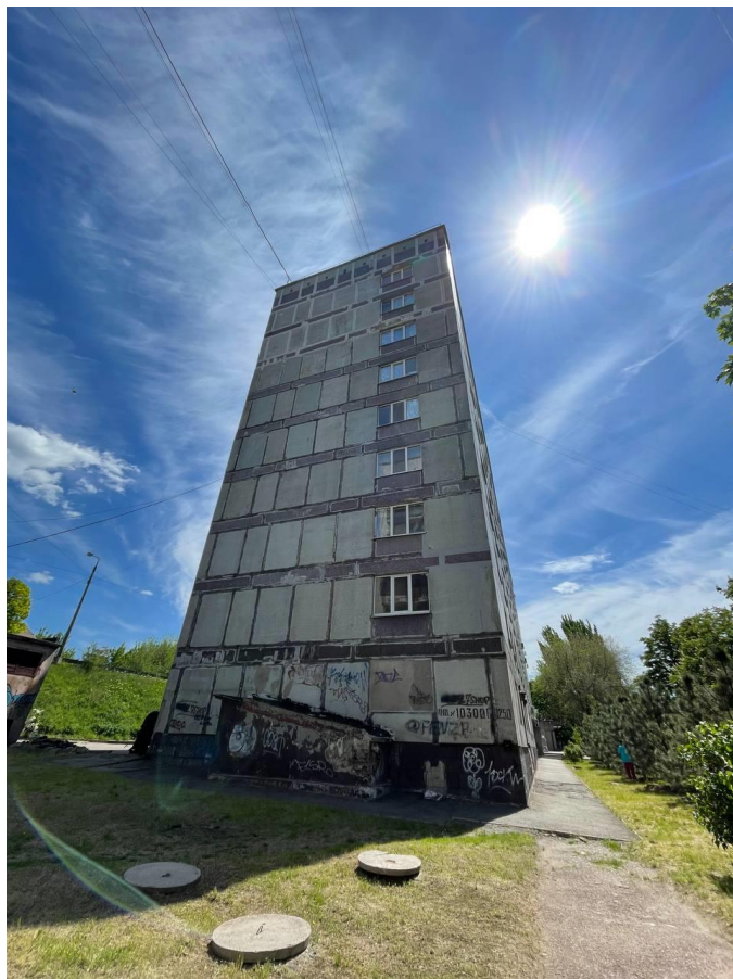
Рисунок 1.3 – Правий фасад будівлі
