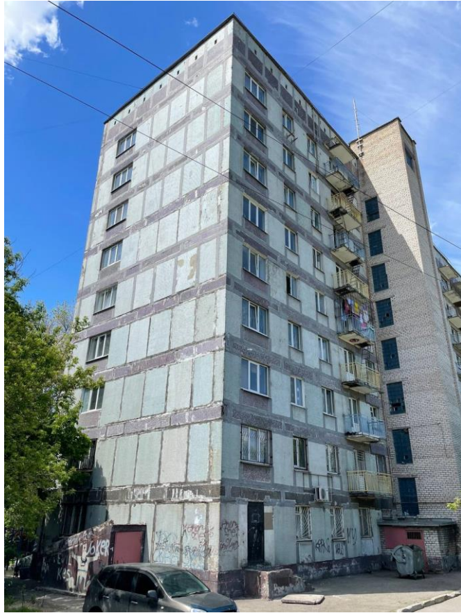
Рисунок 1.2 – Лівий фасад будівлі
