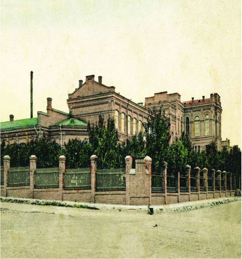
Рисунок 3.1- Будівля головного корпусу НУ «Запорізька політехніка» на початку ХХ століття.
