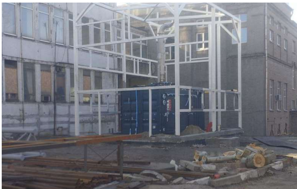
Рисунок 1.3 – Монтаж когенераційної установки
