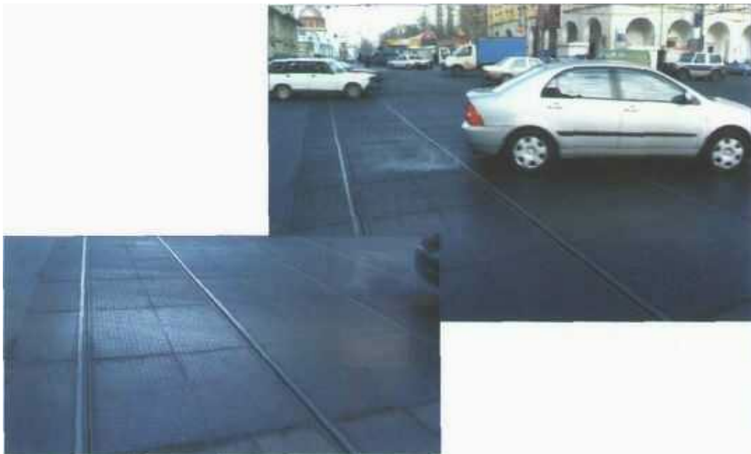
Рисунок 2.2 - Система переїзду трамвайних колій з гумовими панелями
