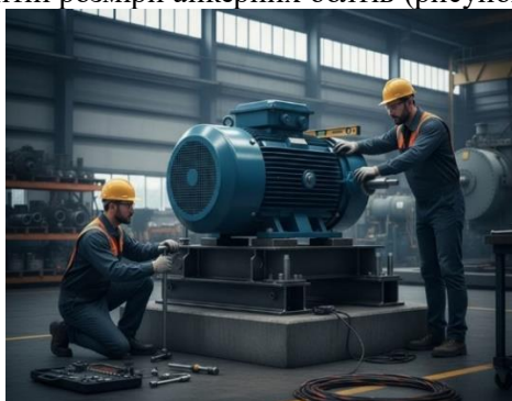
Рисунок 6.2 – Встановлення двигуна на фундамент
