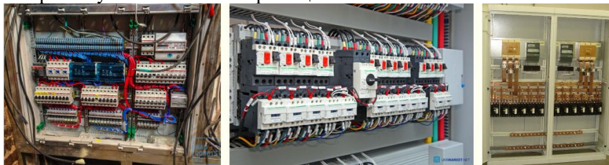
Рисунок 7.2 – Відкриті щитові
