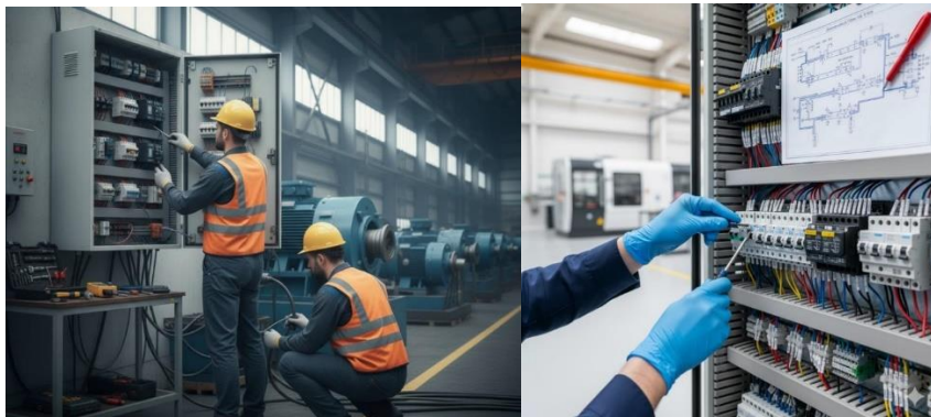
Рисунок 6.8 – Монтаж апаратури керування електроприводу
