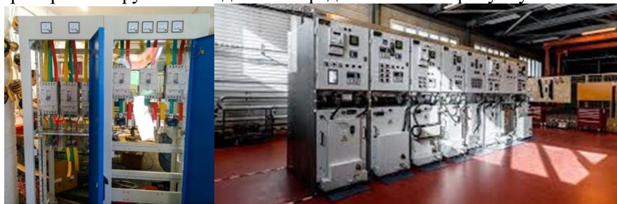
Рисунок 5.2 – Розподільчі пристрої напругою понад 1000В
