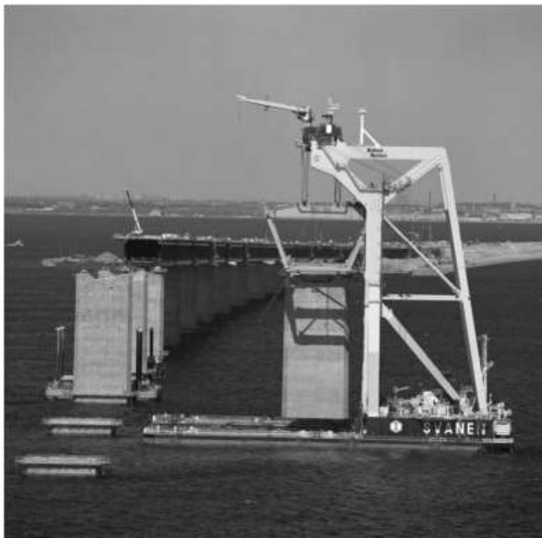
Рисунок 1.13 – Кран «Svanen» зі спеціальним вантажозахватним пристроєм під час монтажу опорної частини мосту.
