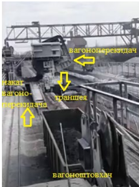
Рисунок 1.1 – Процес вивантаження вагонів на вагоноперекидачі
