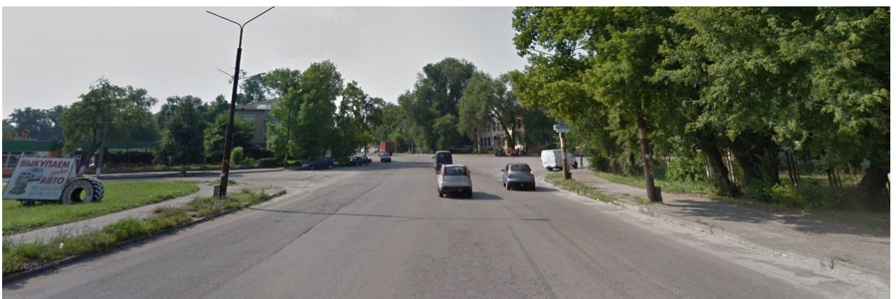
Рисунок 1.5 – Під’їзд до перехрестя вулиці Абрагама Коопа із вулицями Зачиняєва та Героїв 37-го батальйону від Дніпровського шосе
