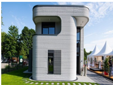
Рисунок 1 – 3D-друк як напрям у будівельній робототехніці
