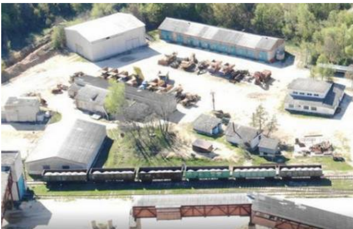
Рисунок 3.1 - Загальний вигляд ділянки навантаження кварциту
