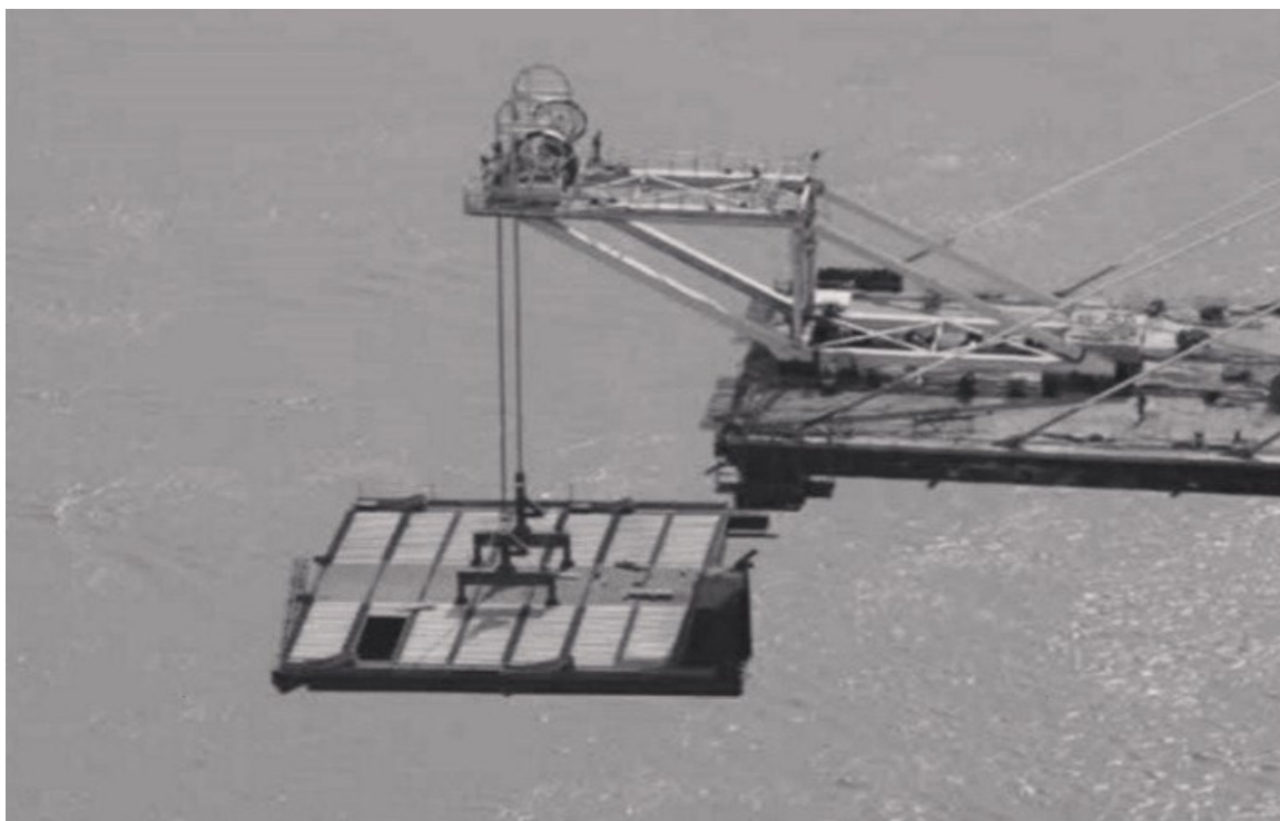
Рис 3.3. - Монтаж сегментів підвісних мостів за допомогою «strand jack»
