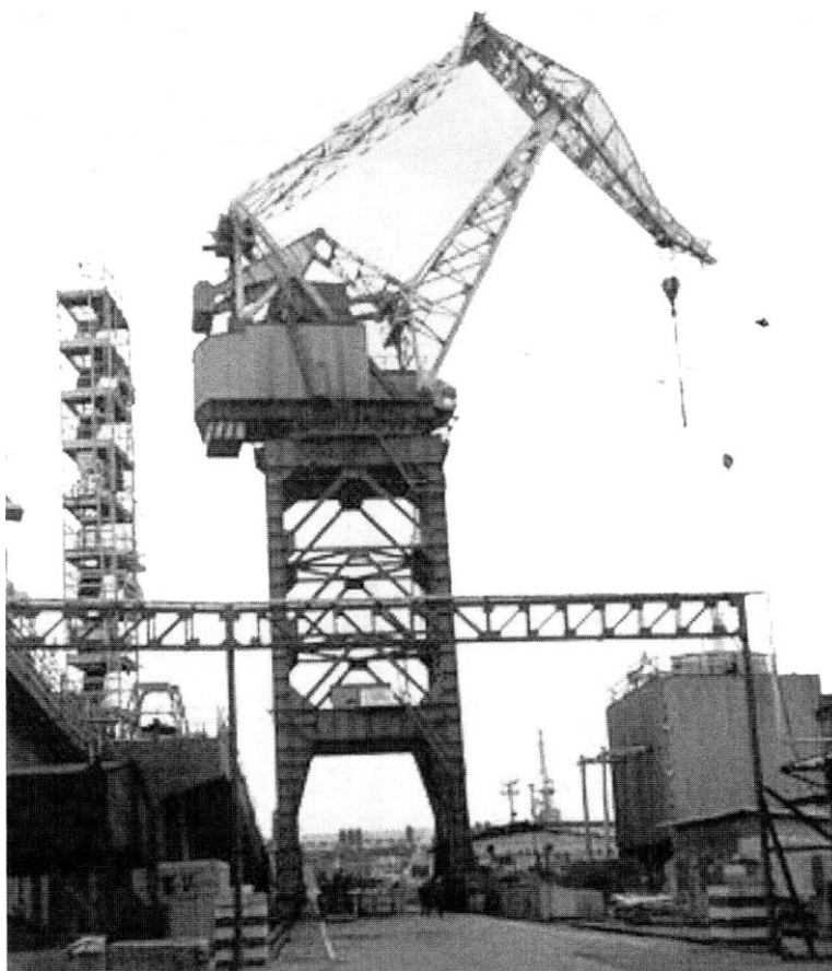
Рисунок 3.6 – Стапельний кран із шарнірно-зчленованою стрілою в/п 75 т
