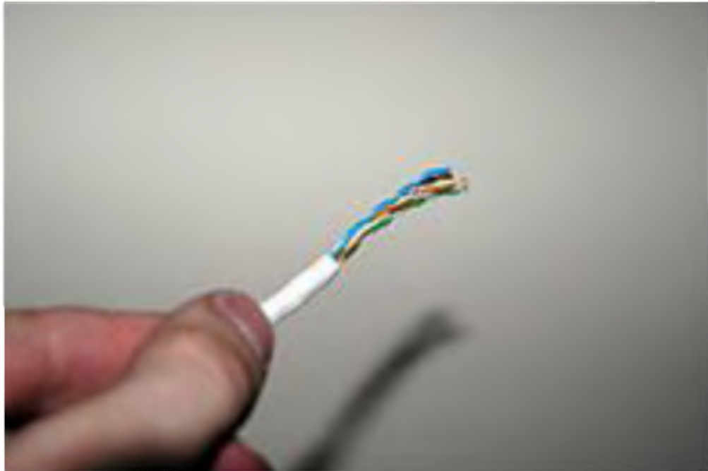
Рисунок 5.2 - Зняття верхньої оболонки кабелю
