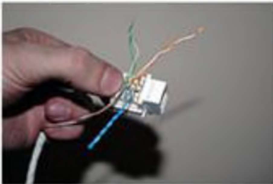
Рисунок 5.3 – Розкладка та закладення кабелю в модулі Keystone
