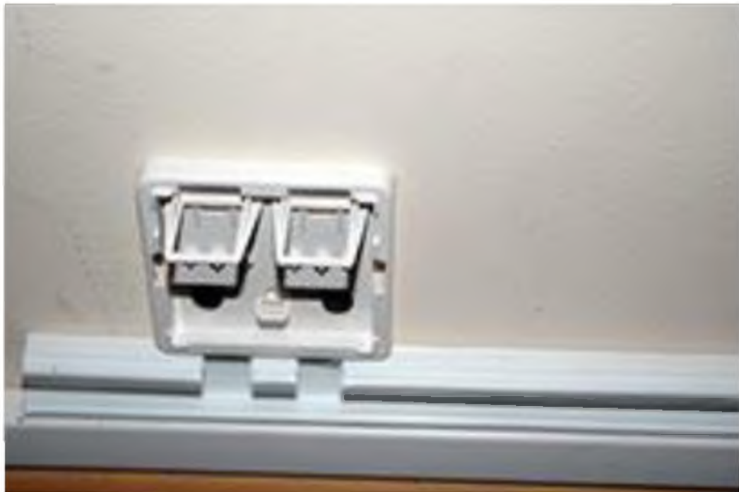
Рисунок 5.1 – Встановлення зовнішньої розетки RJ-45
